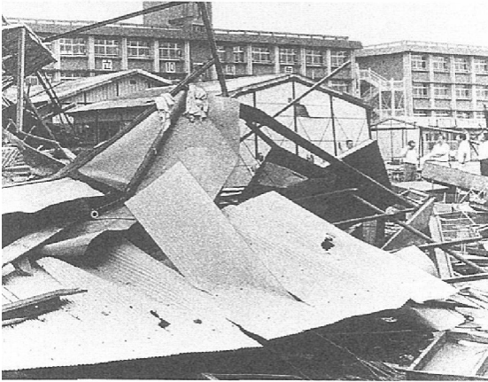
台風13号で倒壊した明和中のプレハブ校舎
